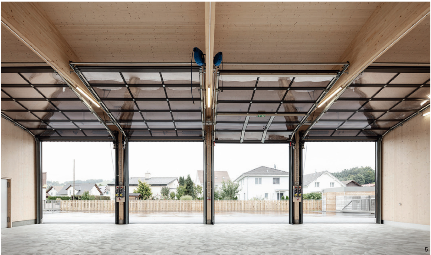
5 Unten Recyclinghartbeton, oben Satteldachträger aus Brettschichtholz. Vom Umschlagplatz erfolgt die Zufahrt in die stützenfreie Einstellhalle durch die vier Tore aus Plexiglas. Dank einer Durchfahrthöhe von 4,2 Metern ist das auch mit grösseren Fahrzeugen möglich.
